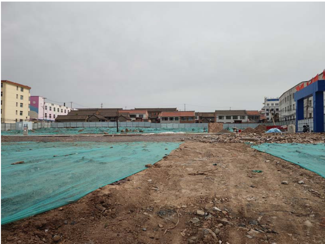
地基开挖前原地貌照片
