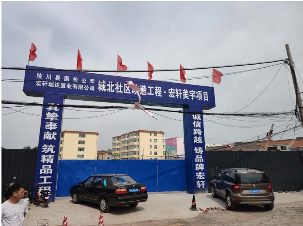
施工进场大门照片
