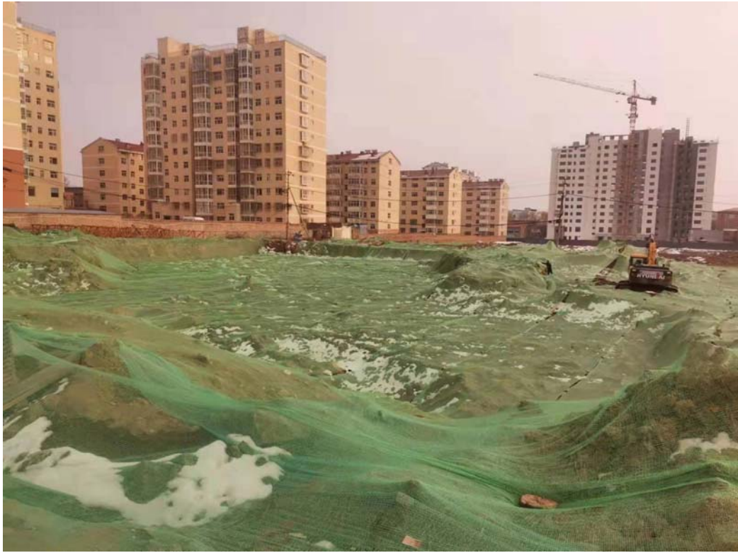
主体工程现状照片
